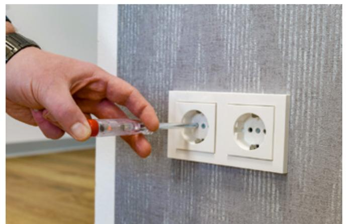
Ein Phasenrichtiger Anschluss ist der erste Schritt zu gutem Klang. Mit einem Phasenprüfer ist dies schnell erledigt. Dazu wird die Spitze in die Steckdose gesteckt und der Finger auf den Kontakt am Ende gelegt. Leuchtet die Glimmlampe, führt die Phase Strom.
